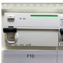
Les dispositifs différentiels résiduels (DDR) protègent contre les chocs électriques et les incendies. On les reconnaît au bouton « test ».
